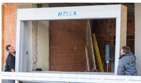
5 TRAV ® frame BEHELYEZÉSE
