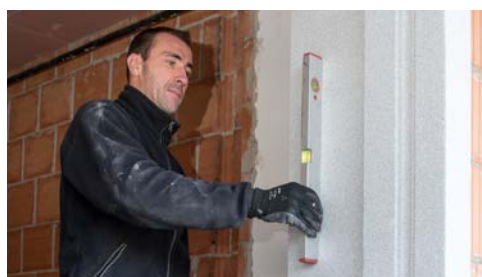
7 TRAV®frame KIIGAZÍTÁSA
